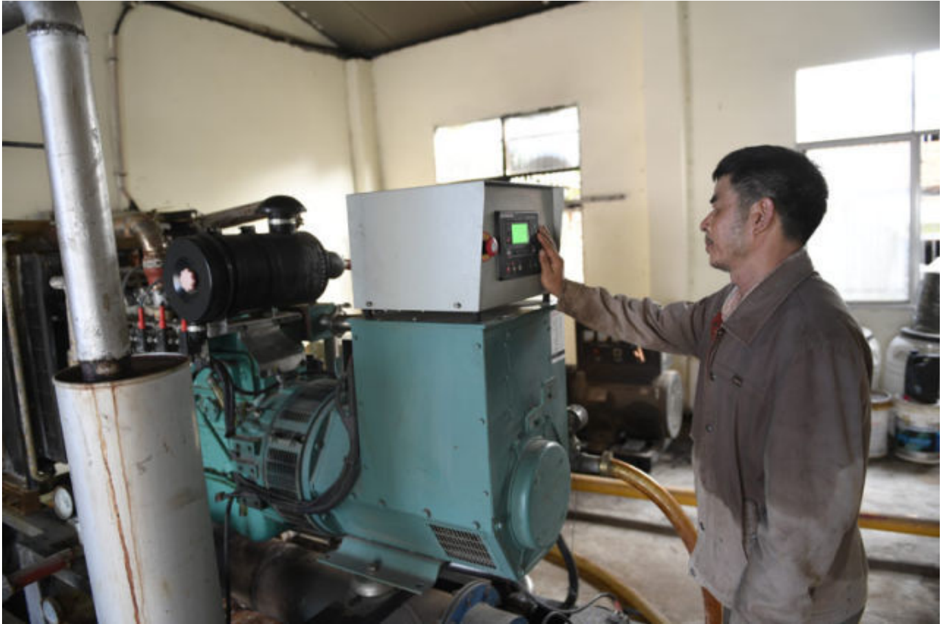
图为四川省广汉绿松养殖有限责任公司生猪繁育产业化示范基地员工在使用沼气发电（8月23日摄）。新华社记者刘坤 摄
